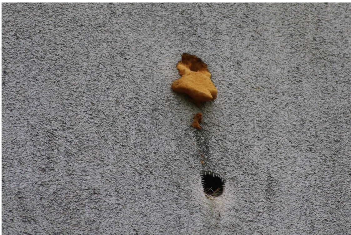
Ryc. 3. Część otworów w elewacji było wypełnionych pianką budowlaną.
